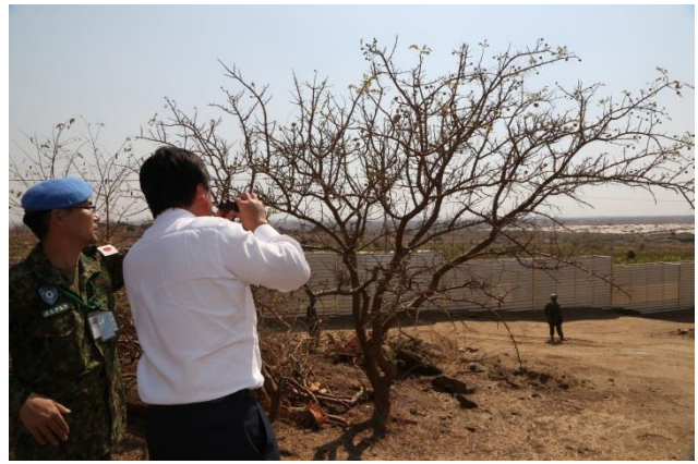
国連ハウス地区外壁構築活動現場
