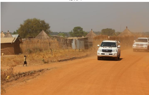
ジュバ～マンガラ間補給幹線道路補修現場へ移動
