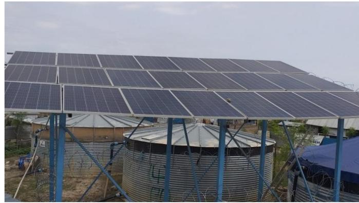
ナイバシャIDP キャンプでは、乾季には、発電機を一切使用していません。また、雨季や天候が悪い日には、太陽光が十分得られないこともあるため、ディーゼル発電機による給水に切り替えられるように設備を整えています。このように、太陽光発電とディーゼル発電機による水供給により、全てのキャンプにおいて、エンジンオイル使用量や二酸化炭素の排出の大幅な削減を達成しつつ、途切れのない支援活動を実施しています。
